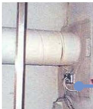
Einbau ohne Brandschutzklappen im „nicht ausgeführtem“ Weichschott!
