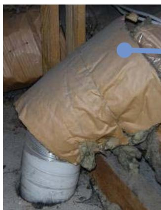
Deckendurchführung ohne Brandschutzklappe und falsche Materialauswahl für die Brandschutzverkleidung
