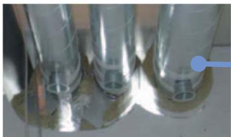
Einbau von Brandschutzklappen im „nicht ausgeführtem“ Weichschott!
